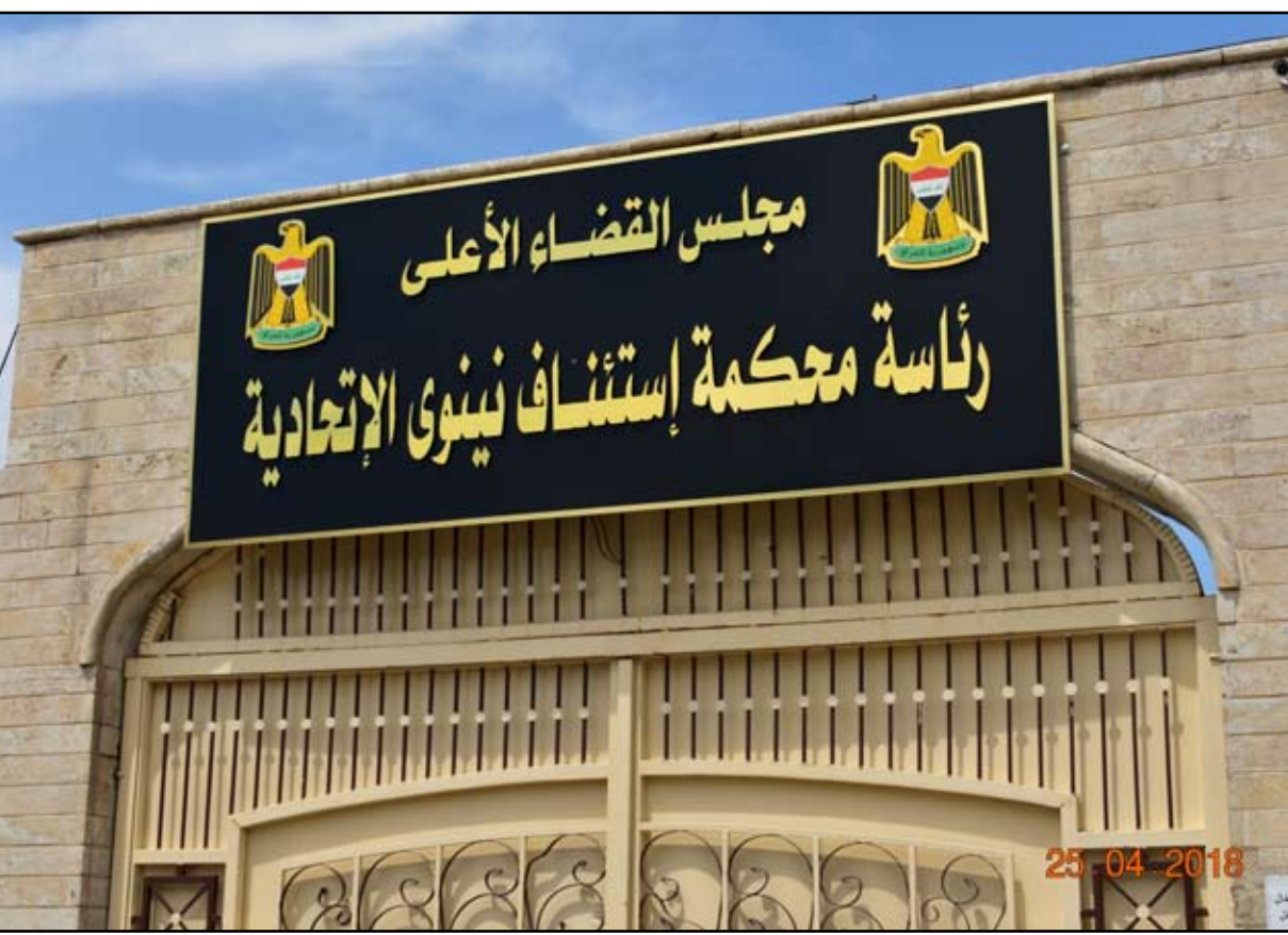
■ واجهة مبنى رئاسة محكمة استئناف نينوى الاتحادية
