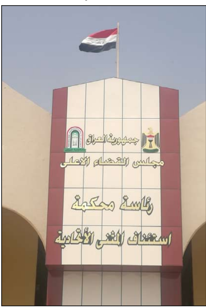
■ واجهة مبنى رئاسة استئناف المنشي
